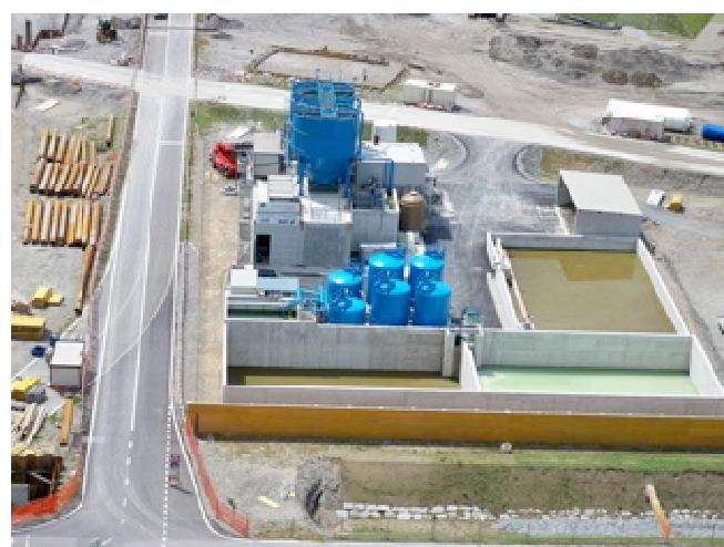
Le contrat du lot 812 porte sur la construction et l'exploitation de deux usines de traitement de l'eau, l'une à Mezzovico (emplacement à mi-chemin entre Lugano et Bellinzona en correspondance de la fenêtre intermédiaire d'attaque du tunnel de base du Ceneri) et l'autre à Vigana (portail nord du tunnel).
