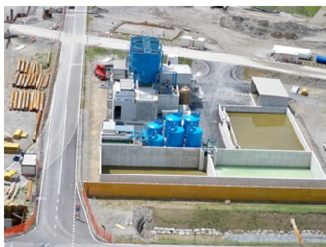
Die Ausschreibung des Loses 812 betrifft die Erstellung von zwei Abwasseraufbereitungsanlagen, die eine in Mezzovico (Ort zwischen Lugano und Bellinzona auf der Höhe der Zwischenöffnung des Ceneri-Basistunnels) und die andere in Vigana (Nordeinfahrt des Tunnels).
